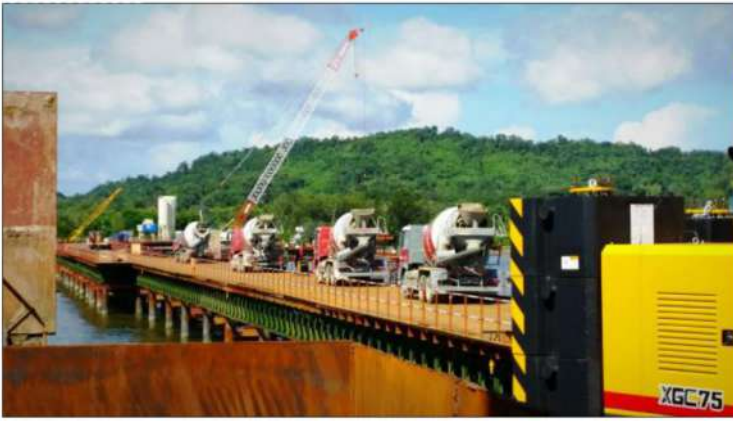
Pulau Muara Besar bridge
